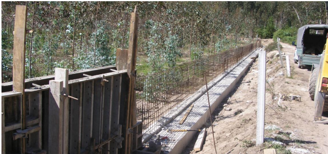
Legenda: Construção de Muro em Betão Armado.
